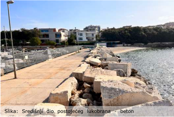
Slika: Središnji dio postojećeg lukobrana - beton
