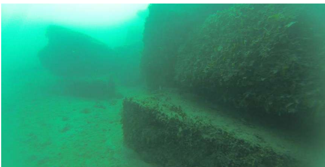
Slika: Kamenomet. Izvor: Elaborat „Podvodni pregled stanja kamenometa (školjere) lukobrana - Pješćana Uvala“, Murgons d.o.o., Pula, veljača 2020.
